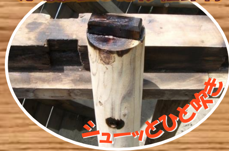
現場加工した修繕部材
