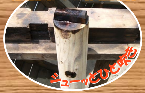
現場加工した修繕部材
