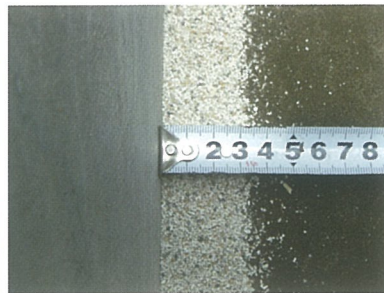
基礎立ち上がり部への散布
