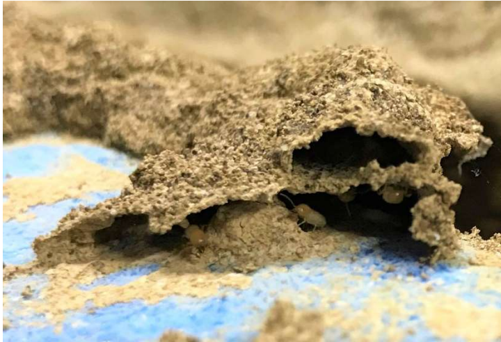
トンネル状の蟻道
